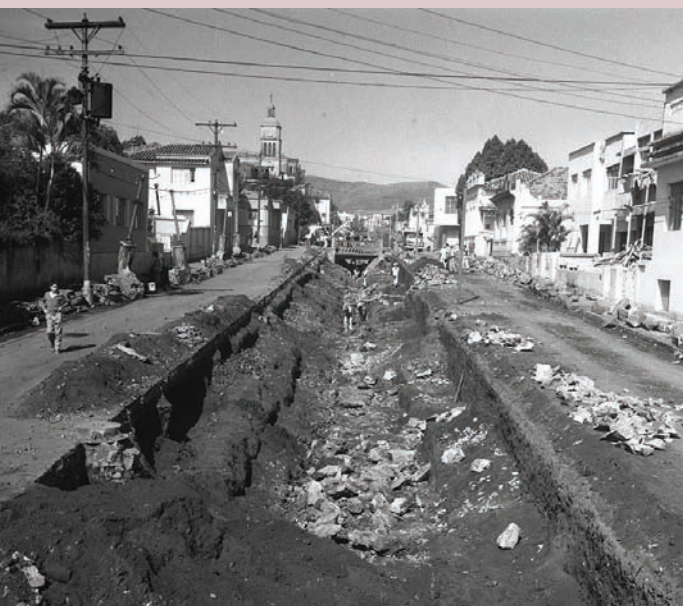
Obra de canalização do córrego Acaba Mundo na rua Professor Moraes, nas imediações da avenida Getúlio Vargas.
