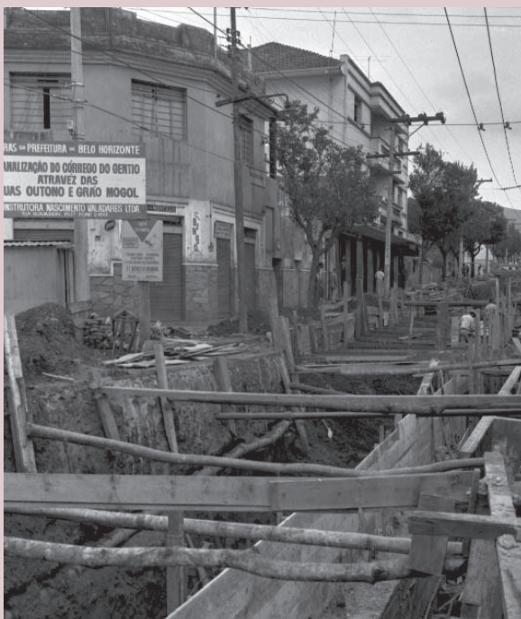
Obra de canalização do córrego do Gentio na av. do Contorno com rua Grão Mogol.
