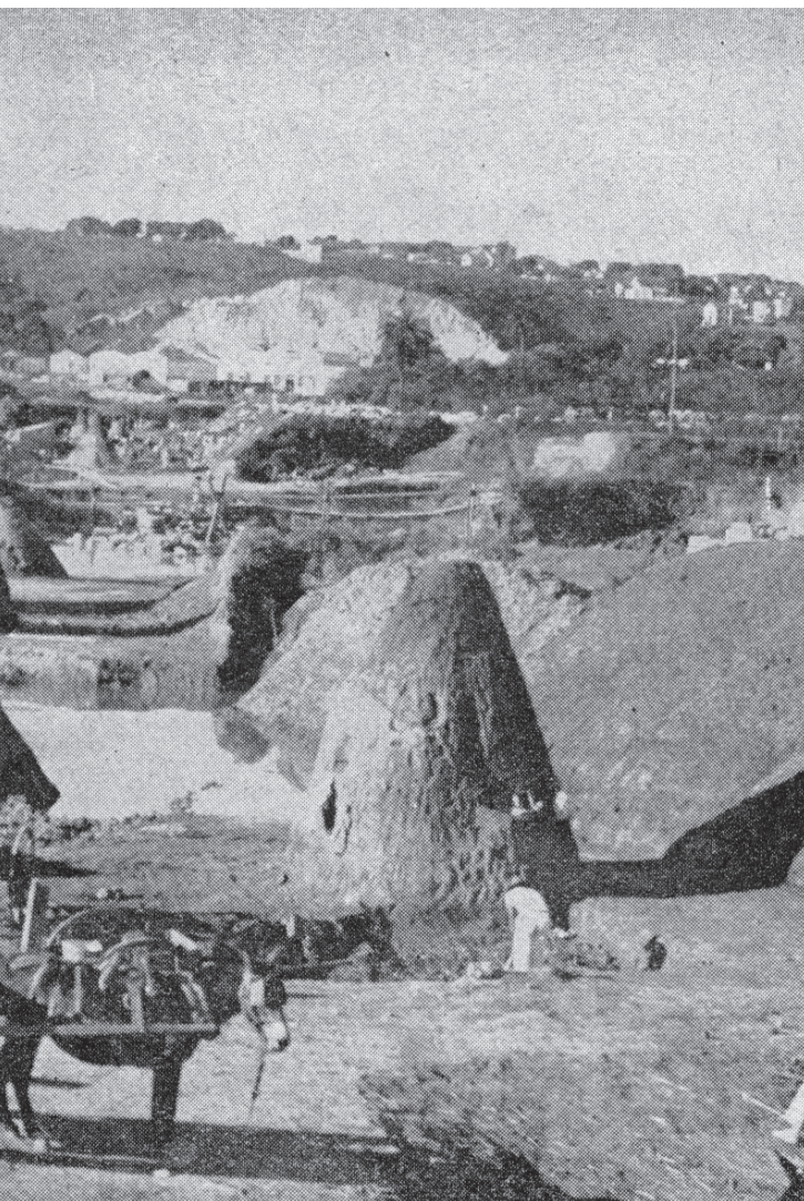
Obras de canalização do Rio Arrudas no Bairro Calafate.
