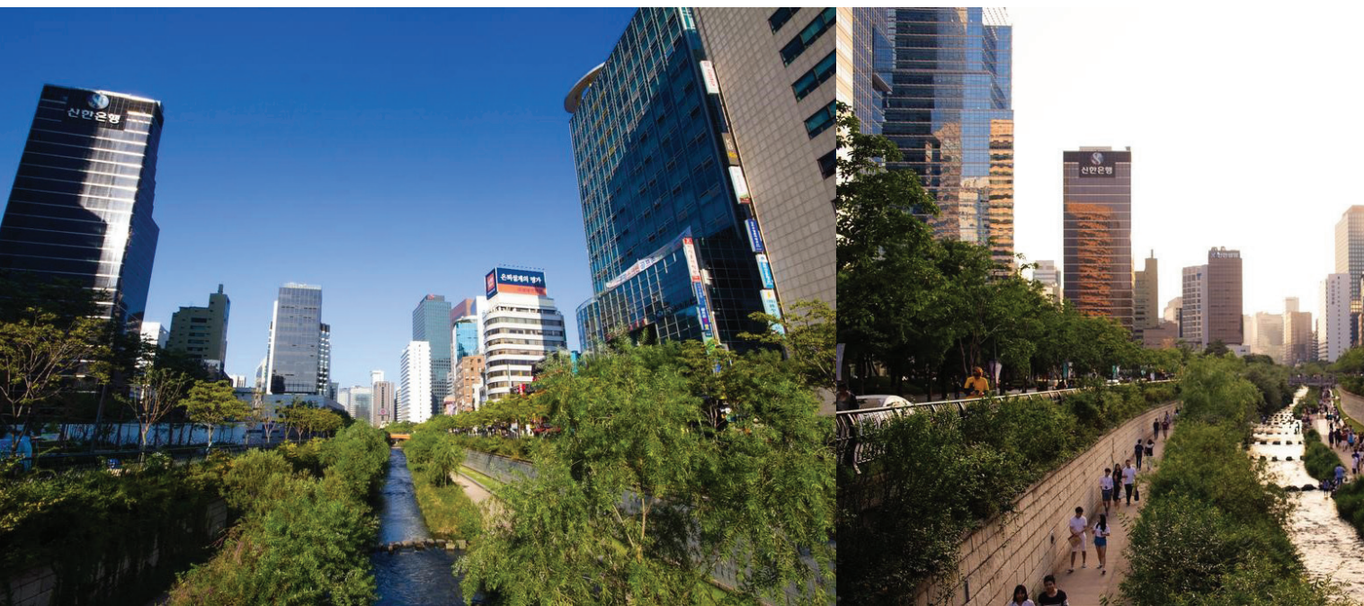
Figuras 3 e 4 - Restauração do Rio Cheong Gye Cheon.
