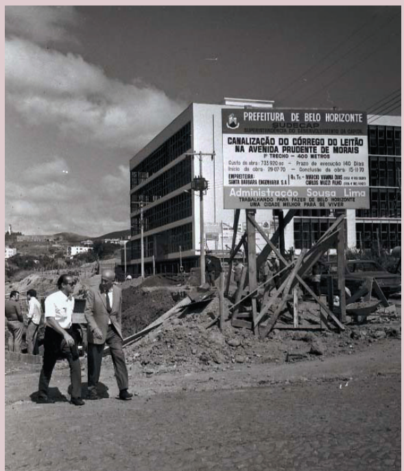
Visita do prefeito Souza Lima as obras de canalização do córrego do Leitão, na avenida Prudente de Moraes, onde se vê à direita o prédio do TRE, em 1970.
