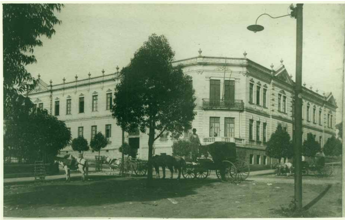
Vista do Grande Hotel de Belo Horizonte (MG) à avenida do Paraopeba (chamada Augusto de Lima a partir de 1935) esquina com rua da Bahia onde mais tarde construiu-se o edifício Arcângelo Maleta. Acervo Museu Histórico Abílio Barreto
