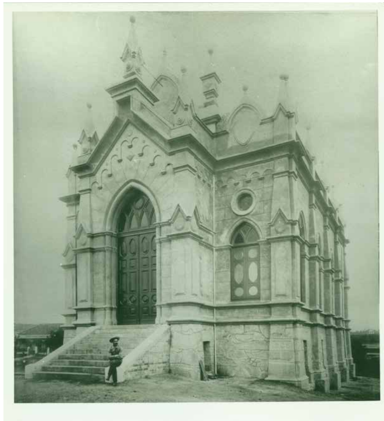
Igreja Metodista, onde hoje é o edifício Acaiaca; fundada em 14 de outubro 1898, foi demolida em 1937. Fotografia entre 1905 e 1908. Acervo Museu Histórico Abílio Barreto
