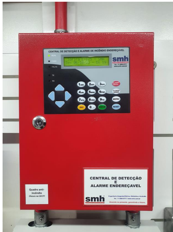
Figura 17: Sistema de detecção e combate a incêndio
