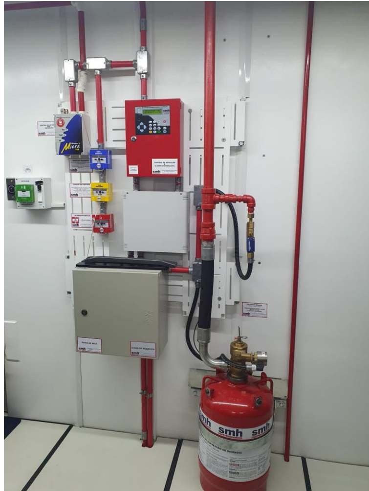
Figura 14: Sistema de detecção e combate a incêndio
