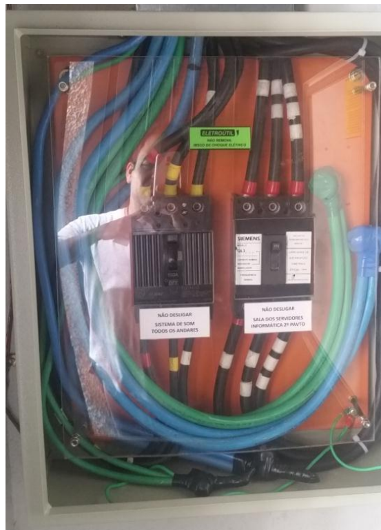
Figura 27: Sistema elétrico – quadro by-pass
