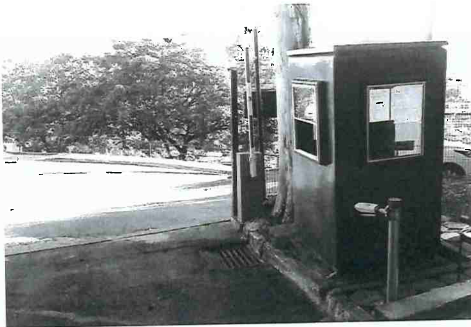
Figura 3 - Visibilidade comprometida devido ao posicionamento da guarita em relação à via principal de entrada dos veículos.
