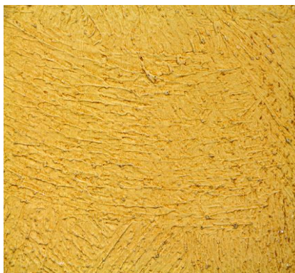
ALVENARIA REVESTIDA COM SUVINIL TEXTURATTO CLÁSSICO NA COR AMERELO GEMA CAPIRA
