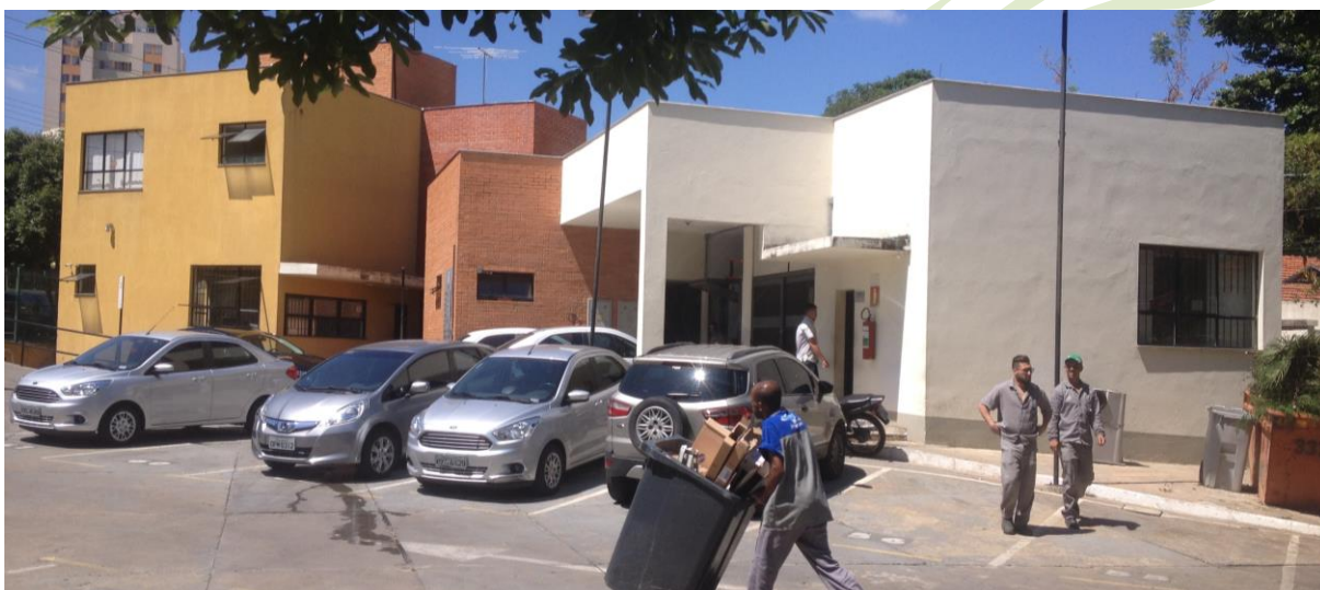
Foto anexo de serviços existente.
