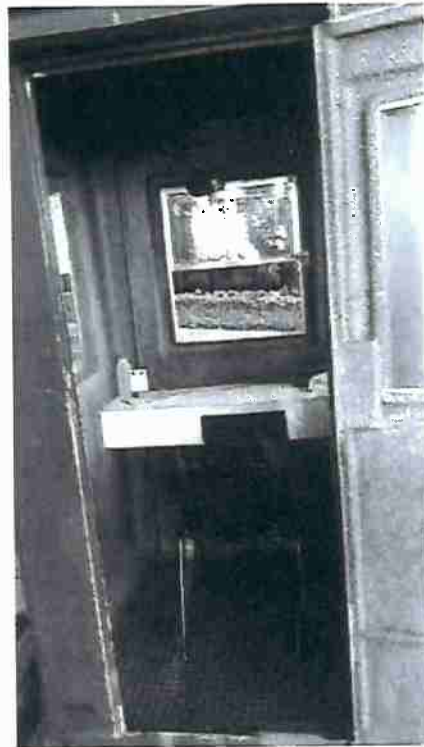
Figura 4 – Interior da guarita: mau desempenho relacionado à mobilidade e à visibilidade do profissional.
