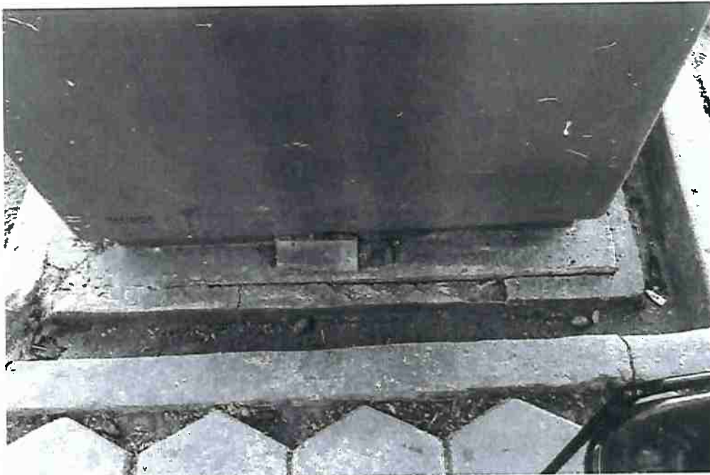
Figura 5 – Patologias aparentes na tampa da fossa que suporta a guarita.
