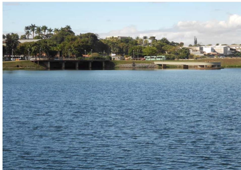
Vista dos Vertedouros da Barragem da Pampulha
