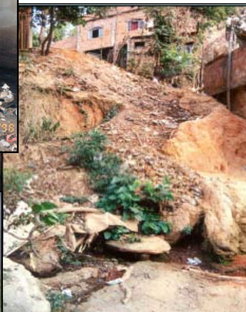
Erosão do solo
