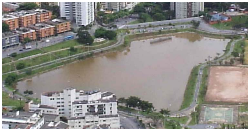
Vista da Barragem de Sta. Lúcia
